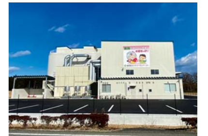
建築工事が完了したカントリーエレベーター
