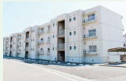
借上げ町営住宅
