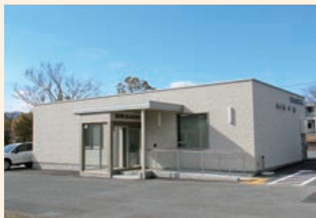
富岡町食品検査所外観
