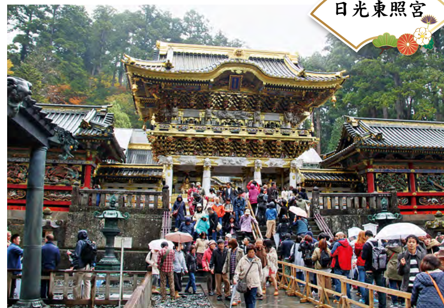
今年3月に平成の大修理を終えた国宝「陽明門」約4年に及ぶ修繕工事で本来の輝きを取り戻した
