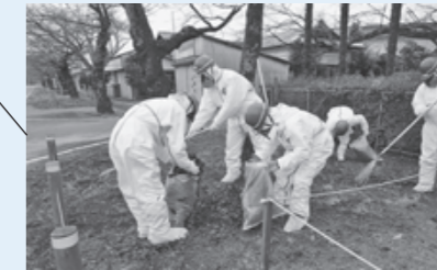
桜通りでの土壌除去作業
