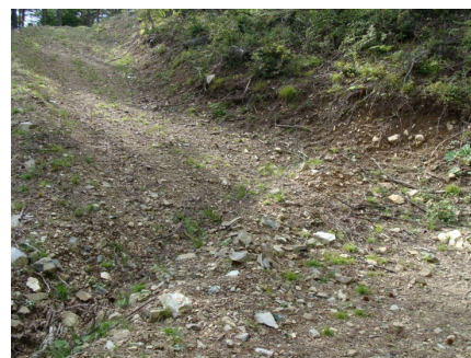
素掘りによる横断溝
