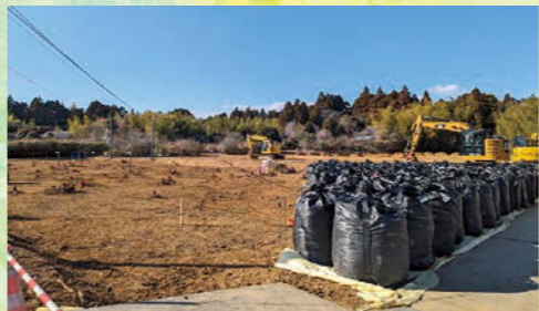
除染作業が進む小良ヶ浜地区
