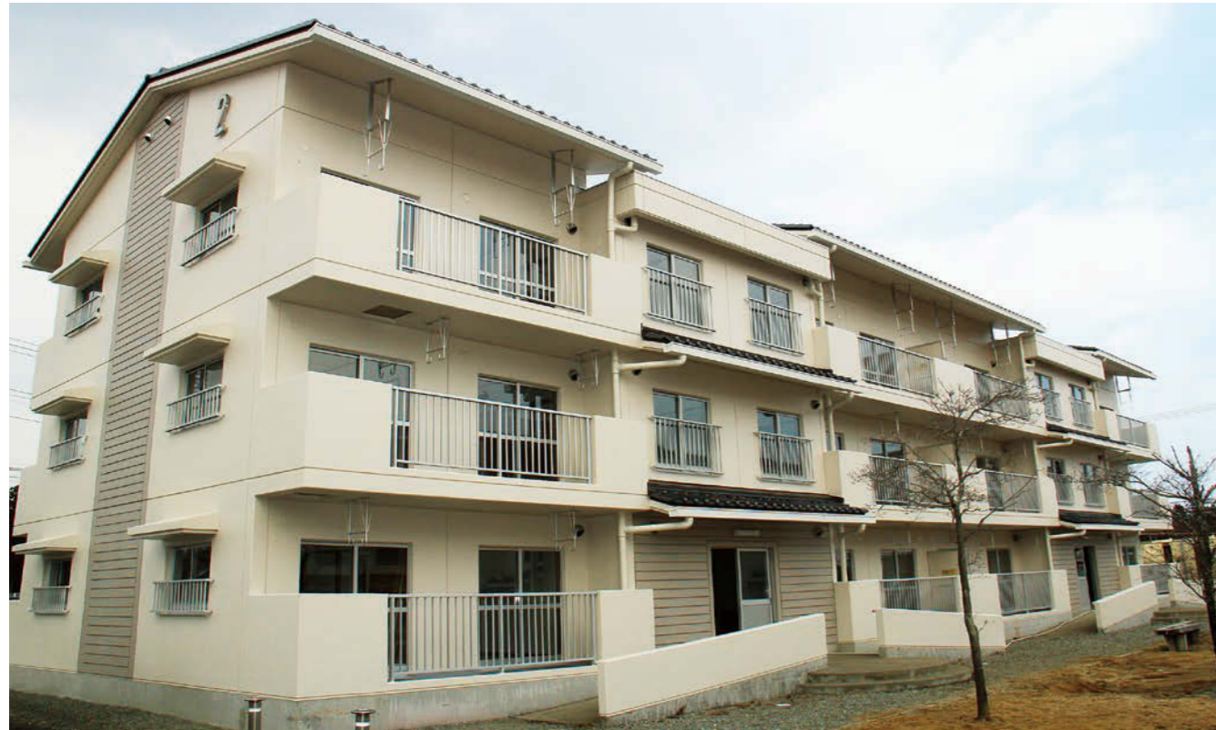
建物全景(写真は2号棟)
