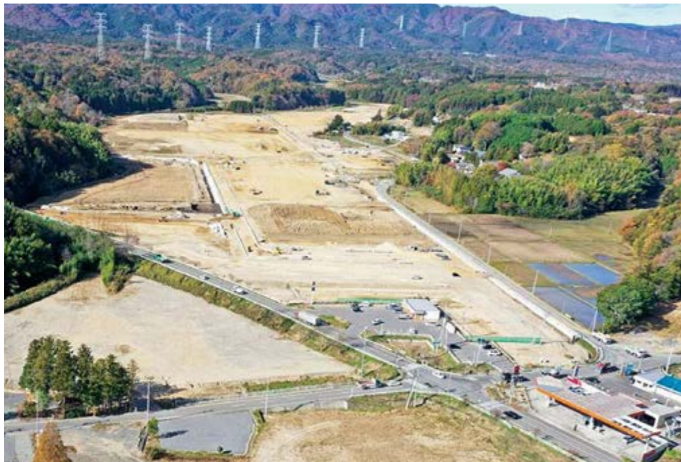
造成工事が進む富岡産業団地建設地
