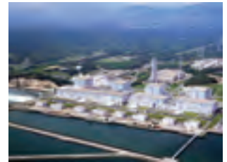
原子力発電所
