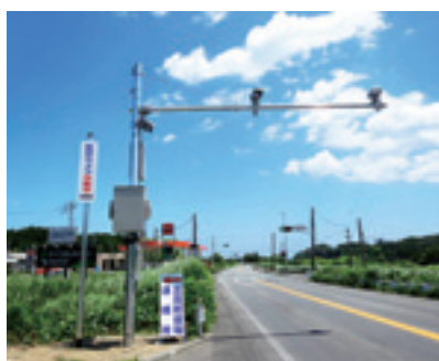
町内約40か所に設置された防犯カメラ
