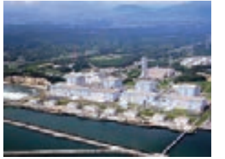
原子力発電所
