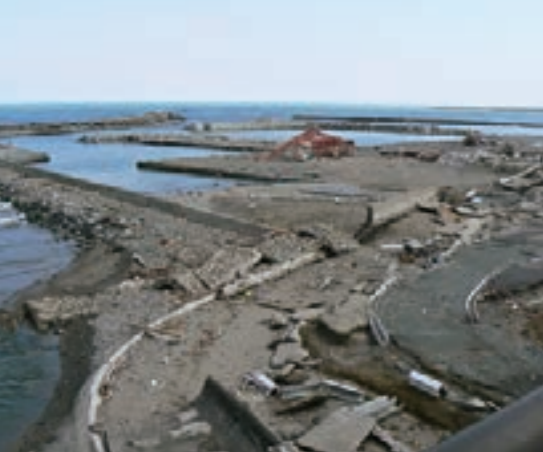
大津波に破壊された富岡漁港
