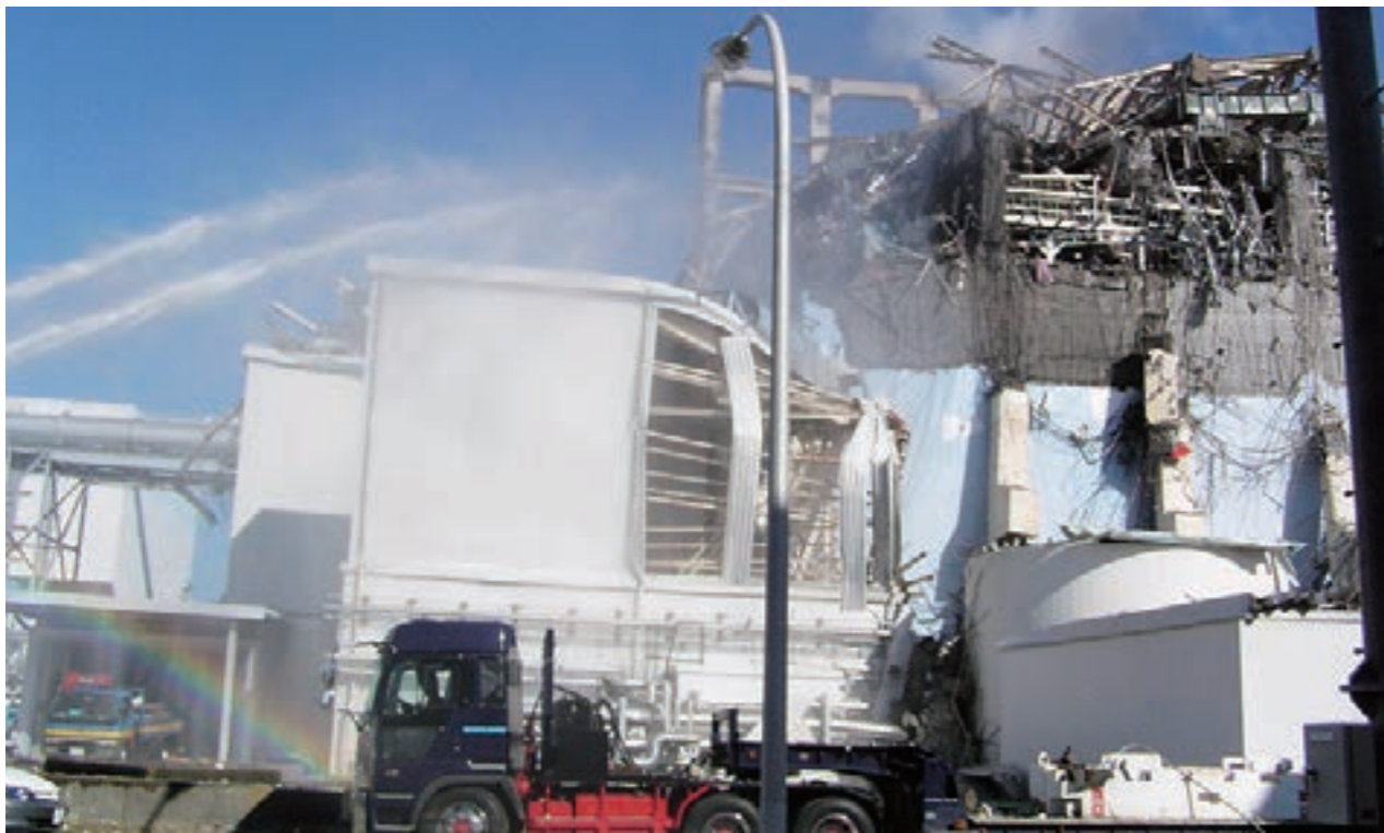
福島第一原発3号機への放水作業
