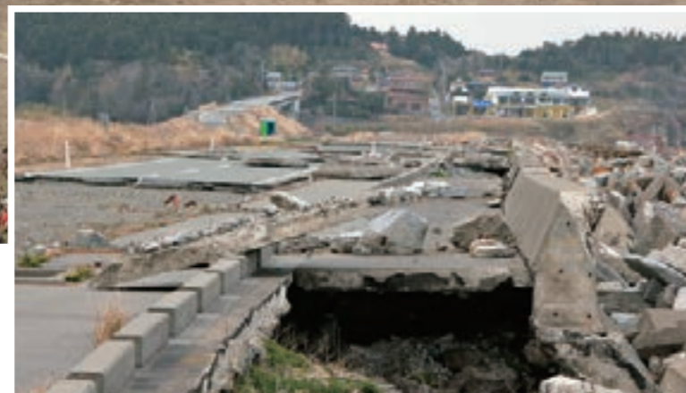
津波で破壊された浜街道
