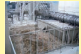
原子炉建屋冠水
