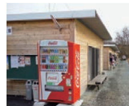
三春町紫原萩久保応急仮設住宅
