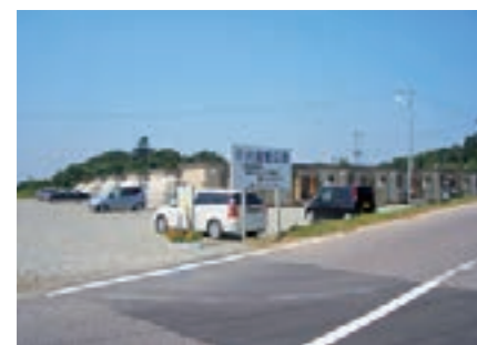
三春町平沢応急仮設住宅
