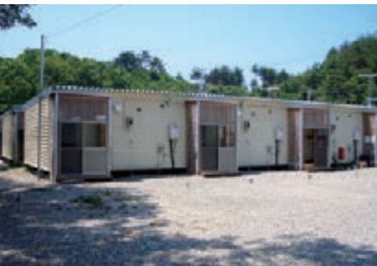
三春町熊耳応急仮設住宅
