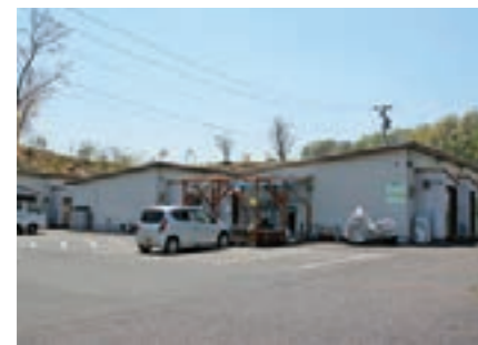
三春町もみじ山応急仮設住宅
