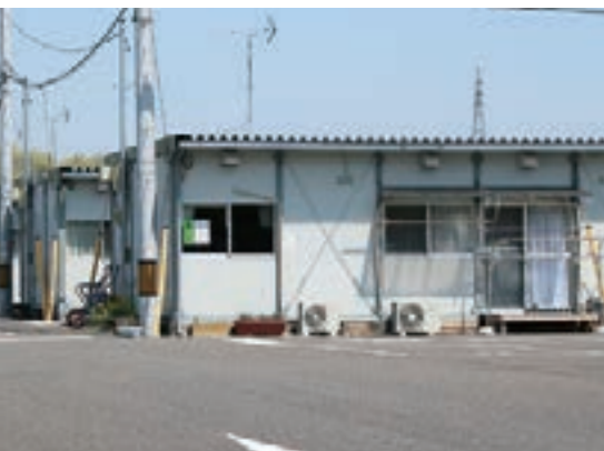
郡山市緑ヶ丘東7丁目応急仮設住宅
