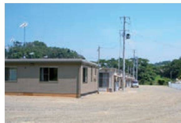
三春町沢石応急仮設住宅
