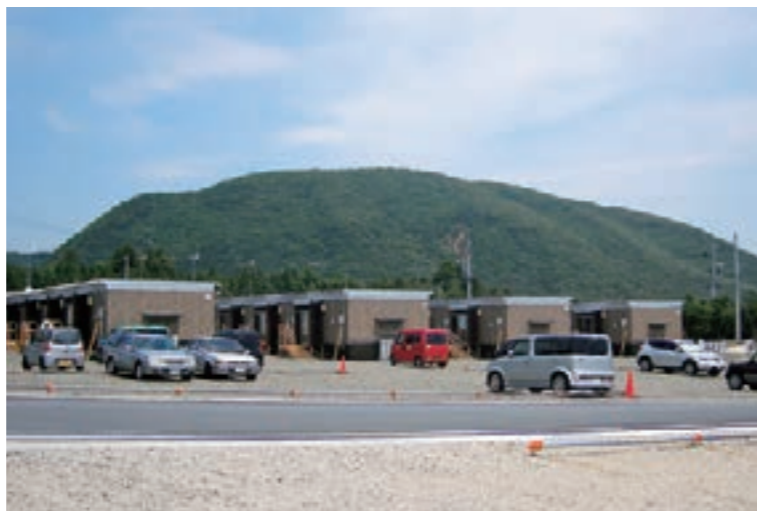
大玉村安達太良応急仮設住宅
