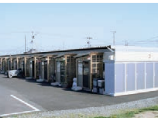
郡山市富田町若宮前応急仮設住宅
