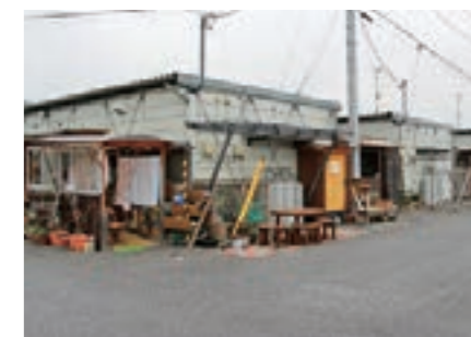
いわき市好間応急仮設住宅
