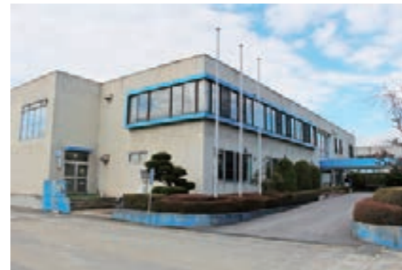
町立幼稚園・小中学校の開設【三春町】(平成23年9月1日)
