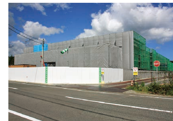
現在建設中の野菜集出荷施設
