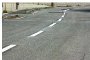
中央線を引き直すなどの改善が進んでいます
