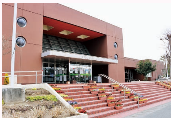
地震により被害を受けた総合体育館
