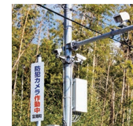
設置中の防犯カメラ
