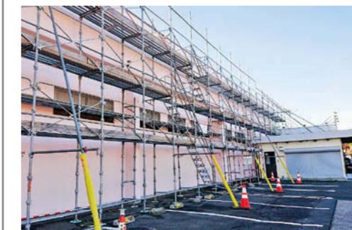
足場のかかったさくらモール
