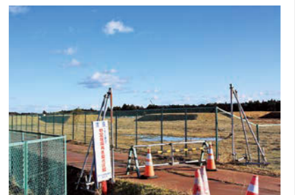
拠点区域外となっている小良ヶ浜地区
