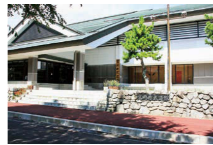
富岡町武道館
