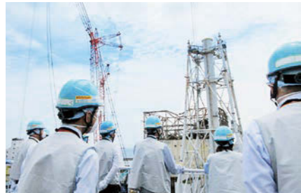
1号機原子炉建屋および2020年に解体された排気筒
