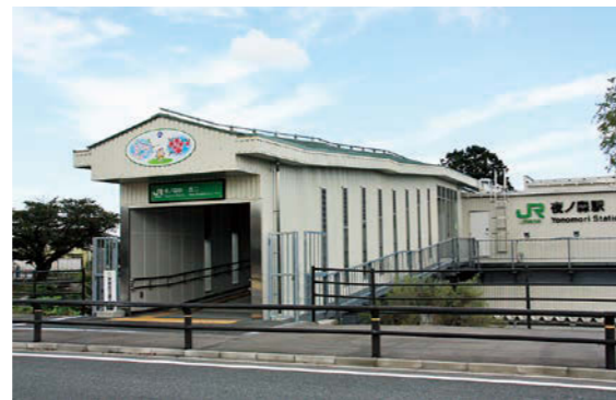
令和2年11月共用の夜ノ森駅東西自由通路
