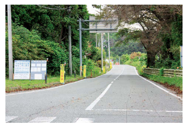
蛇谷須地区と富岡地区の下水道処理区を統合するための接続管渠工事(県道小野富岡線)
