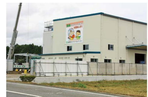
整備が進められるカントリーエレベーター
