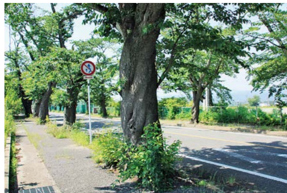
雑草の繁茂する植樹マス
