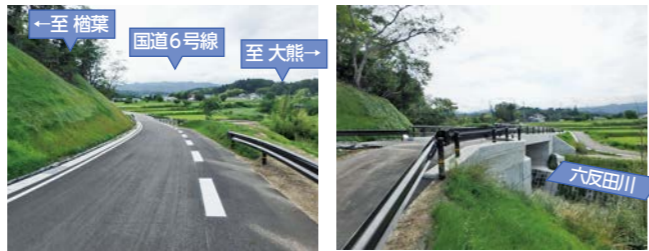
整備された六反田2号線(上郡山太田地内)
