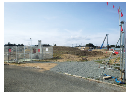
解体の旧リフレ富岡跡地
