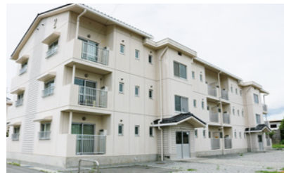
今後、改修される新田団地
