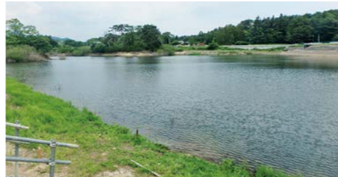
再工事が必要な家老ため池
