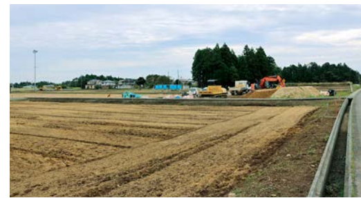
除染が進む特定復興再生拠点区域
