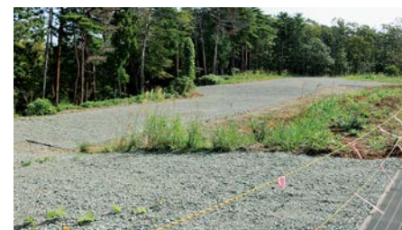
解体され更地となった旧合宿センター
