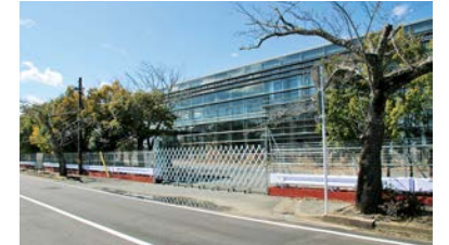
環境省による解体工事が進むリフレ富岡
