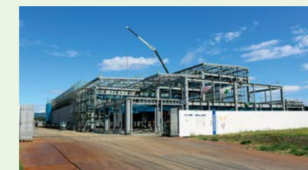
順調に進む建築工事
