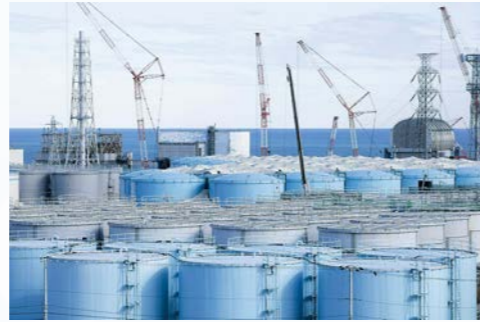
1F敷地内に設置されたタンク群
