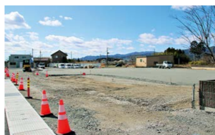
整備が進む夜ノ森駅西口
