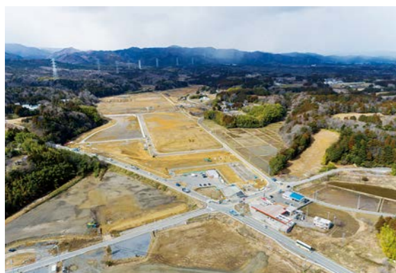
一部供用が開始される産業団地
