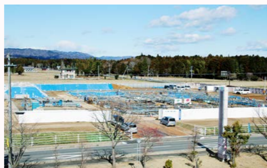
【令和3年夏開所予定】 本格的な建築工事が始まったアーカイブ施設
