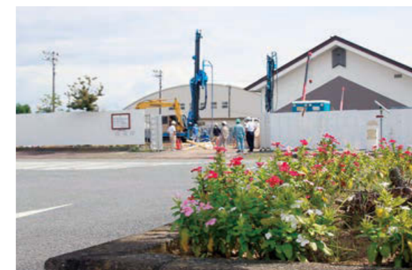
総合スポーツセンター敷地内に整備される拠点倉庫
