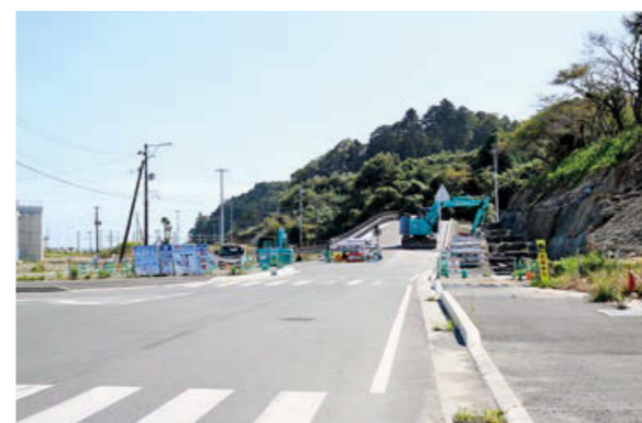
整備が進む駅前周辺道路①
