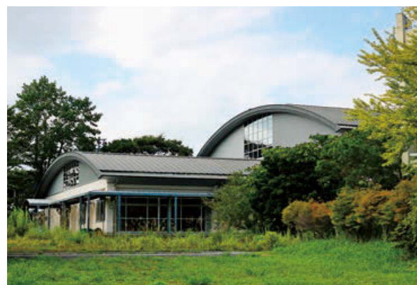
活用が期待される第二小学校体育館
