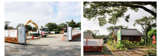
工事の進む夜ノ森駅前広場
