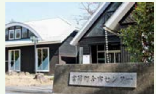
解体予定の既存の合宿センター
