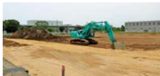
学びの森西側にて造成工事実施中
