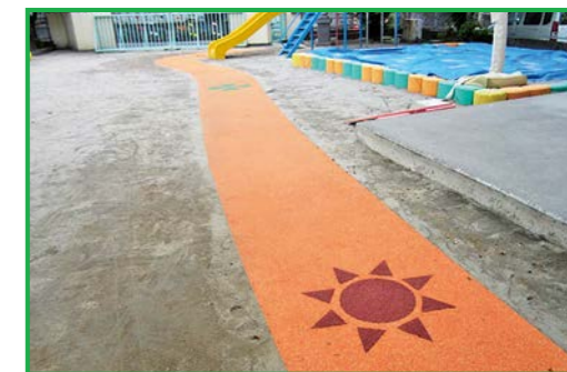
プール通路をゴムチップ舗装(イメージ)
