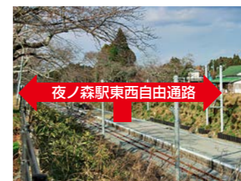
夜ノ森駅東西自由通路新設
