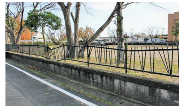
北側フェンスを更新
