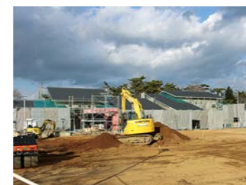
富岡保育所(改修中)
