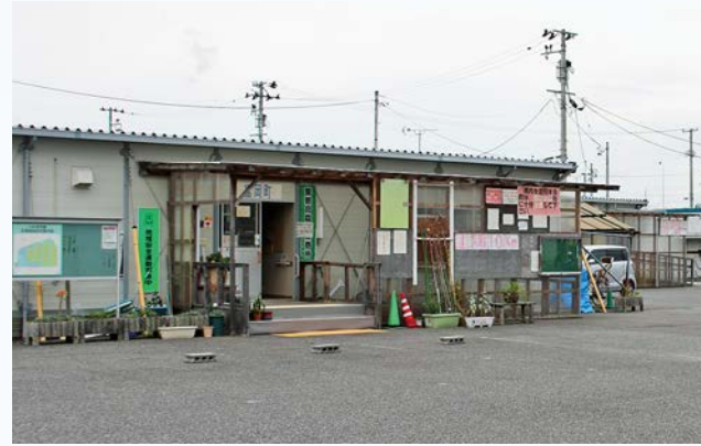
応急仮設住宅維持管理費 (管理委託料、光熱水費等) 1億1200万円
