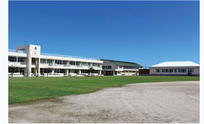
第一中学校施設整備事業費 (施設改修工事費等) 7億3511万円
