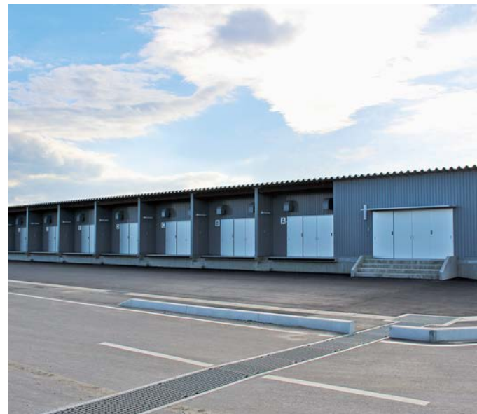
富岡漁港水産業共同施設
