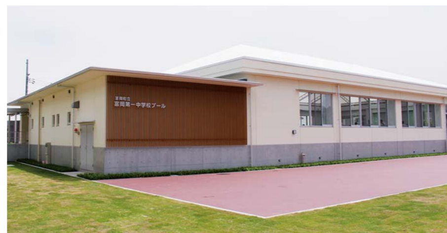
富岡第一中学校プール外観
