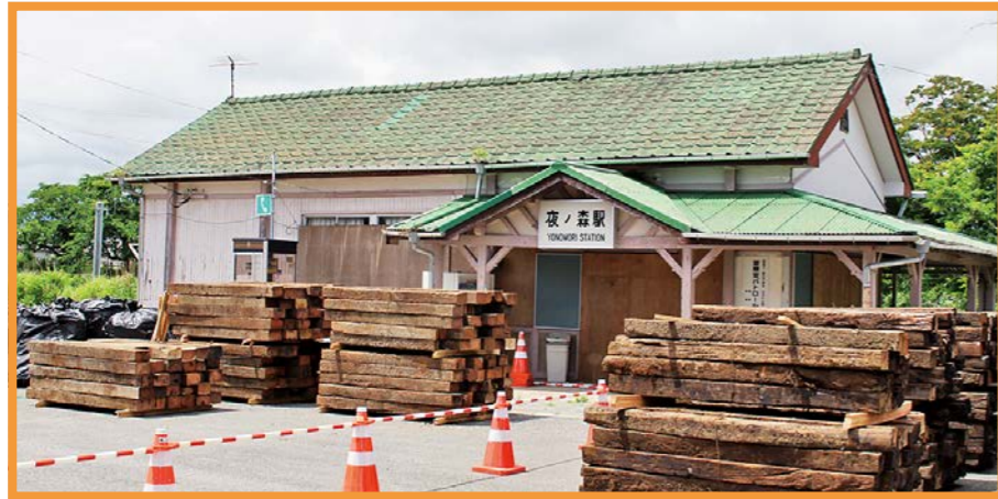
既存の夜ノ森駅舎は解体予定
