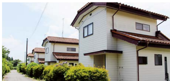
王塚第二町営住宅
