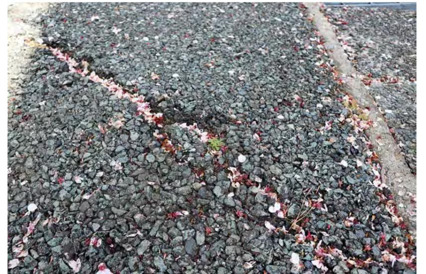
亀裂が補修されていない歩道
