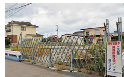
解体に制限のある帰還困難区域内の建物
