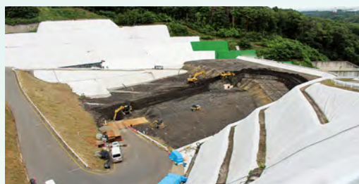
処分場整地状況
