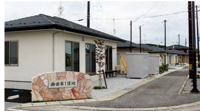
《公営住宅整備事業費：およそ16億7102万円》 ※P3土木費
