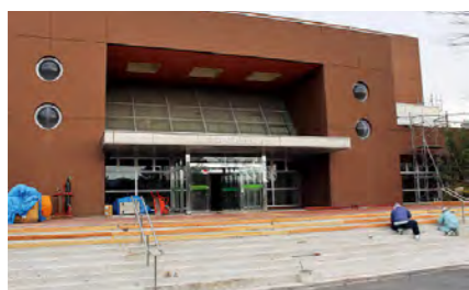
総合体育館の現況
