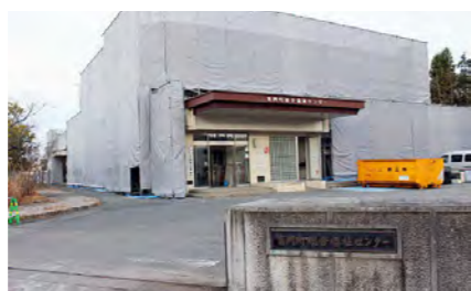
総合福祉センターの現況
