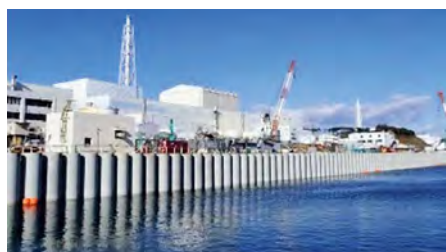
海側遮水壁の現状
