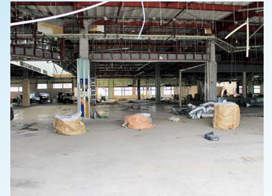
今冬オープンに向け、撤去作業が進む
