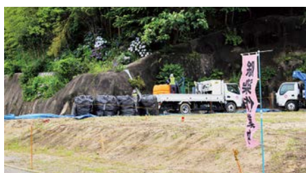
町内各所で再除染を実施中
