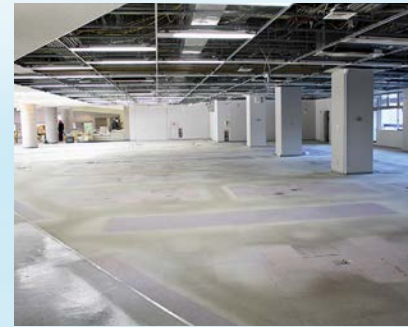
机、椅子など全て撤出されている
