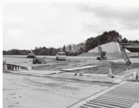
造成中の富岡工業団地(本岡地区)
