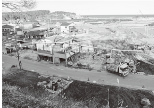
富岡駅前の家屋解体の現況
