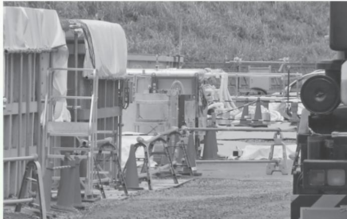
原子炉建屋周囲に設置される凍土遮水壁
