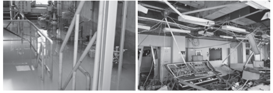
震災直後の富岡浄化センター
