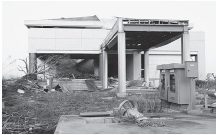
富岡浄化センターの外観
