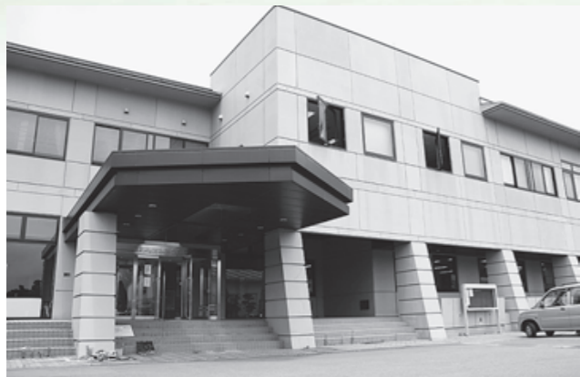
双葉地方水道企業団事務所の2階に復旧課を設置
