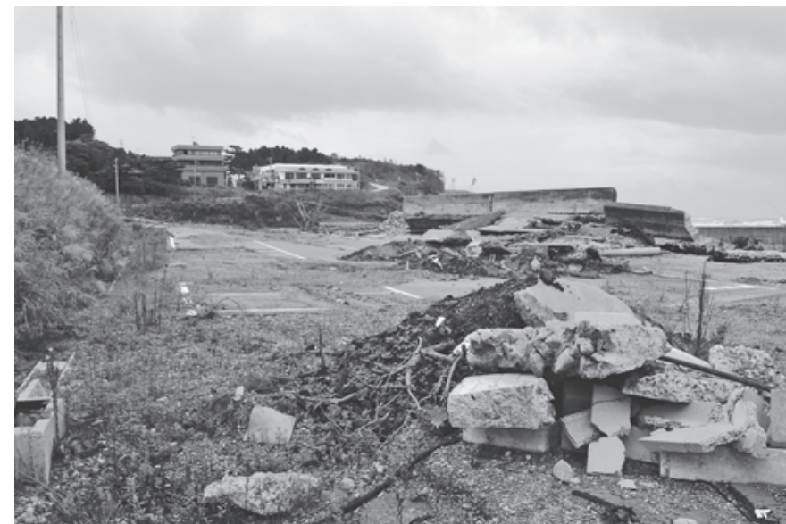
震災後の富岡漁港付近
