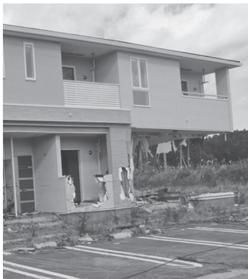
津波被害の現況
