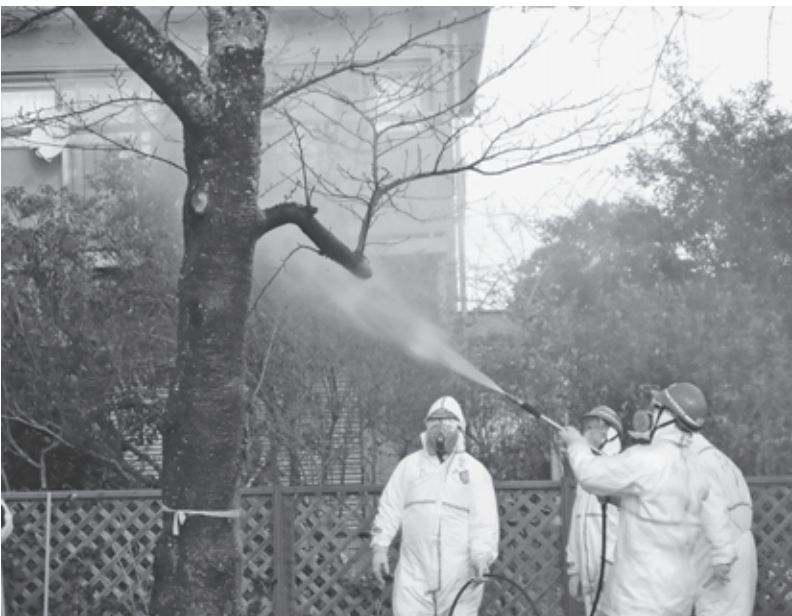
樹木の除染モデル実証事業状況(夜の森地区)
