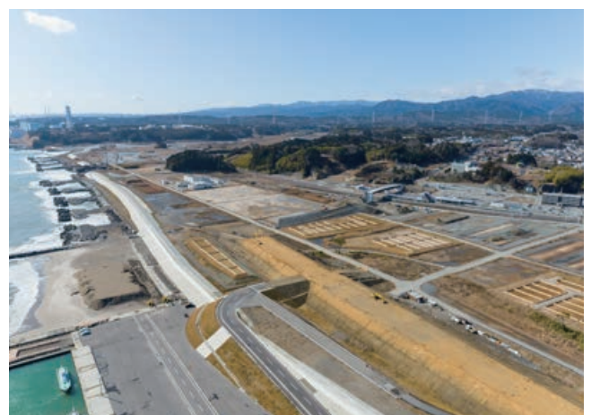
防潮堤・県道嵩上げ・海岸防災林
