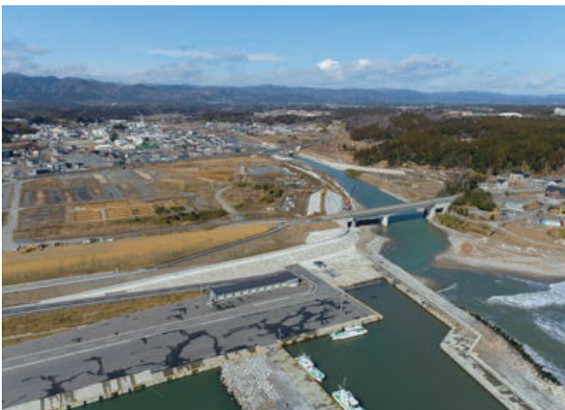
富岡漁港・富岡川河口
