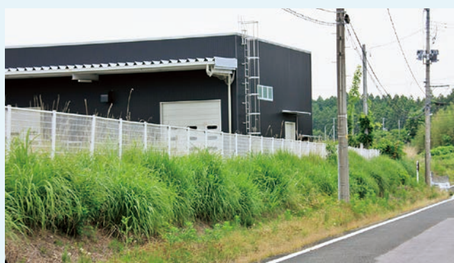
防災備蓄北部倉庫の東側法面
