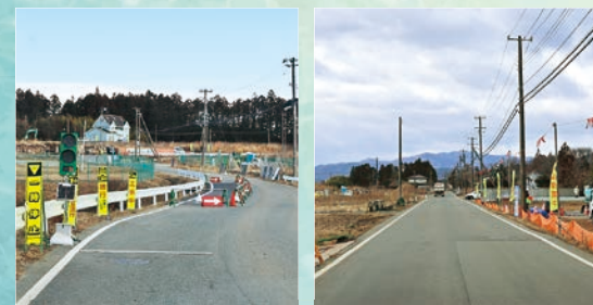
復旧工事等が進む小良ヶ浜地区(左)と深谷地区
