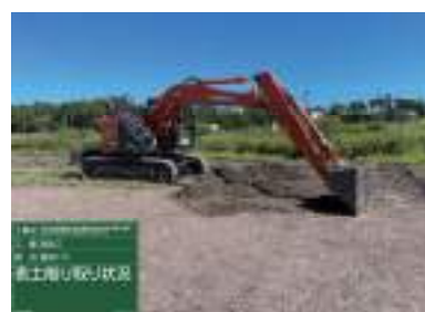
農地の除染(表土の剥ぎ取り)
