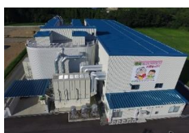
カントリーエレベーター （150 ㍏ 規模） 米の乾燥・貯蔵施設 令和4年産米から稼働
