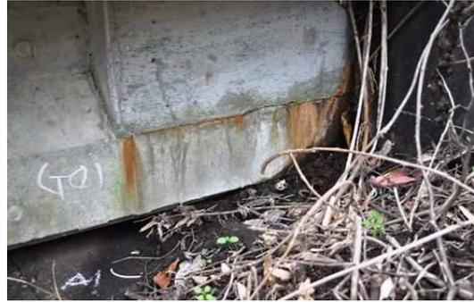
端横桁PC定着部の遊離石灰 (錆汁伴う)
