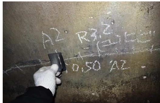
側壁の水平方向ひびわれ(遊離石灰を伴う)
