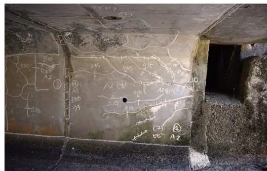
側壁の遊離石灰(錆汁混入)を伴うひびわれ
