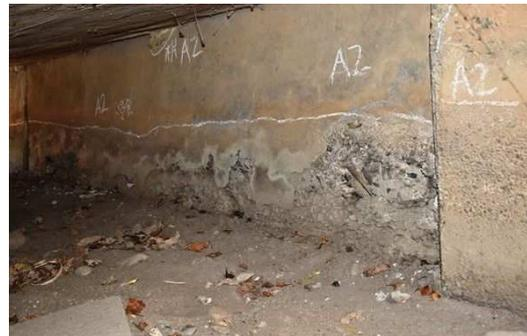
下部工前面の欠損
