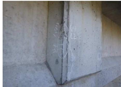
中間横桁PC定着部の剥離、うき
