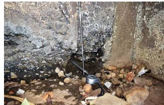
下部工前面の欠損
