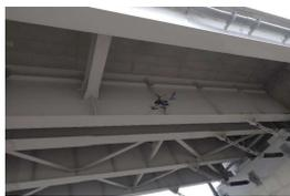
ドローンによる桁下の点検
